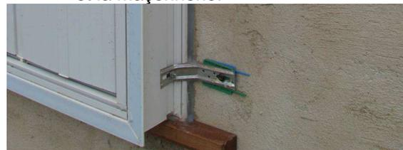
Un pont thermique subsiste au contact entre le châssis de la menuiserie et la maçonnerie. Il aurait été préférable d'y insérer une plaque d'isolant thermique. Les joints d'étanchéité à l'air sont appliqués entre la menuiserie et la maçonnerie.
