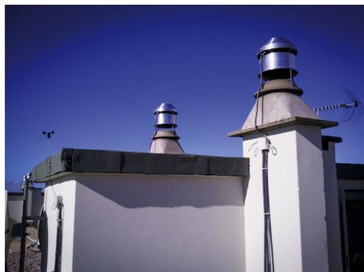
**Figure 32 : Préparation des conduits avant pose du plenum et de l'extracteur (cas dalle non conservée)**
