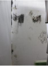
Figure 6 : Apparition de moisissures à la suite de l'isolation de vieux murs. De gauche à droite : moisissures sur mur extérieur, humidité dans les murs par suite de l'installation d'un voile étanche sous le plancher, traces de moisissures dans un mur de refend (sources : AQC).
