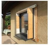
Figure 16 : Fenêtre posée en applique en attente d'une ITE
