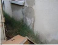
Figure 5 : Pathologies observées après rénovation. De gauche à droite : présence de salpêtre (source : humidites.fr), présence de moisissures sur mur intérieur (source : prix-immobilier info), trace d'humidité et enduit extérieur dégradé (source : Enertech).
