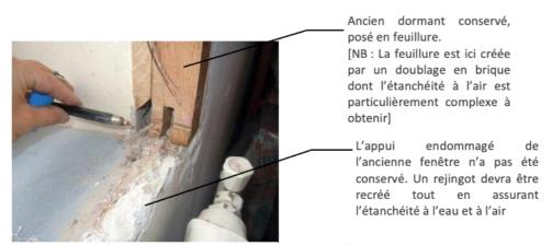
Figure 17 : Défaut d'étanchéité d'un dormant conservé en prévision d'une pose en rénovation de la nouvelle menuiserie
